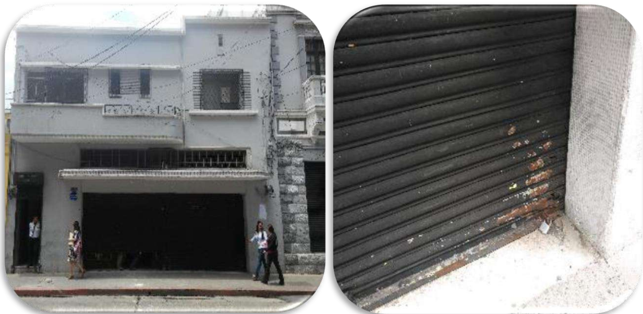
Remodelación del Anexo II, estado actual del inmueble
