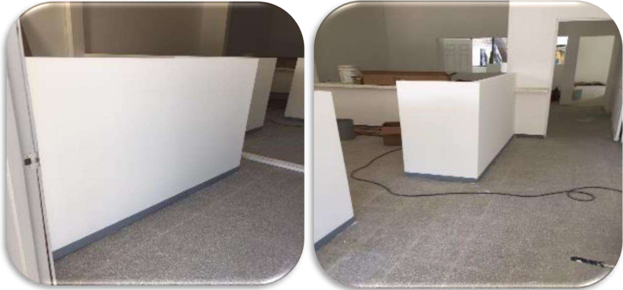
Remodelación de la Coordinación Departamental de Puerto Barrios
