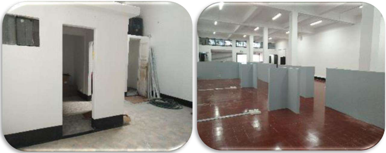
Condiciones en las que se encuentra el inmueble post- trabajos de adecuación
